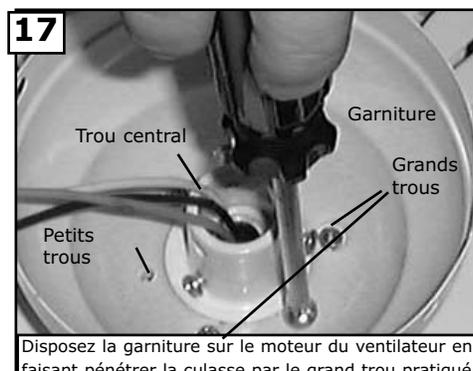
**17** Disposez la garniture sur le moteur du ventilateur en faisant pénétrer la culasse par le grand trou pratiqué au centre de la garniture. Alignez les 3 grands trous autour du trou central avec les 3 vis installées dans le ventilateur. Installez les 3 vis de montage encastré dans les trous les plus petits et serrez à fond.
