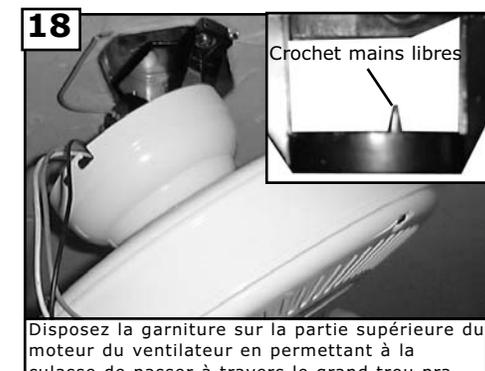
**18** Disposez la garniture sur la partie supérieure du moteur du ventilateur en permettant à la culasse de passer à travers le grand trou pratiqué au centre de la garniture. Alignez les 3 grands trous autour du trou central avec les 3 vis déjà installées sur le ventilateur. Installez les 3 vis de montage encastré fournis dans les petits trous et serrez à fond.
