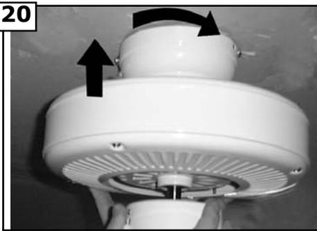
Prenez le support de suspension, et alignez les trous en forme de « L » avec les vis situées sur le support de suspension. Faites pivoter le support dans le sens des aiguilles d'une montre pour le mettre en position bloquée. Remettre en place les vis que vous avez retirées à l'étape précédente et serrez à fond.
