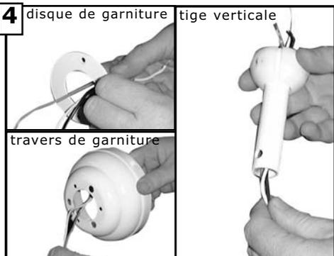
**4** Faites passer les fils de connexion et le câble de sécurité d'abord à travers le disque de garniture, la garniture et enfin la tige verticale.
